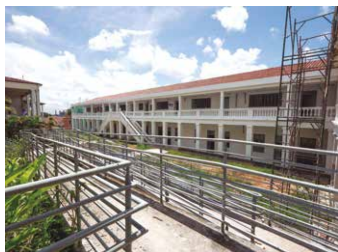
Estrutura é reforçada para a instalação de novos serviços
