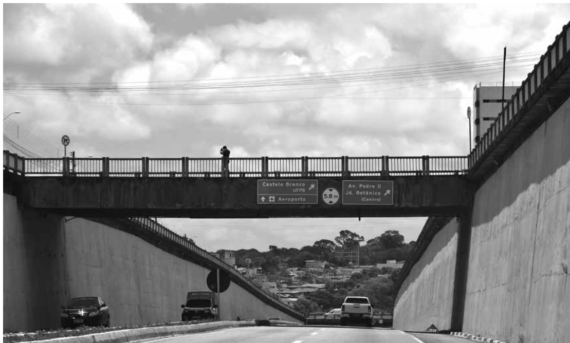
Moldura de concreto
