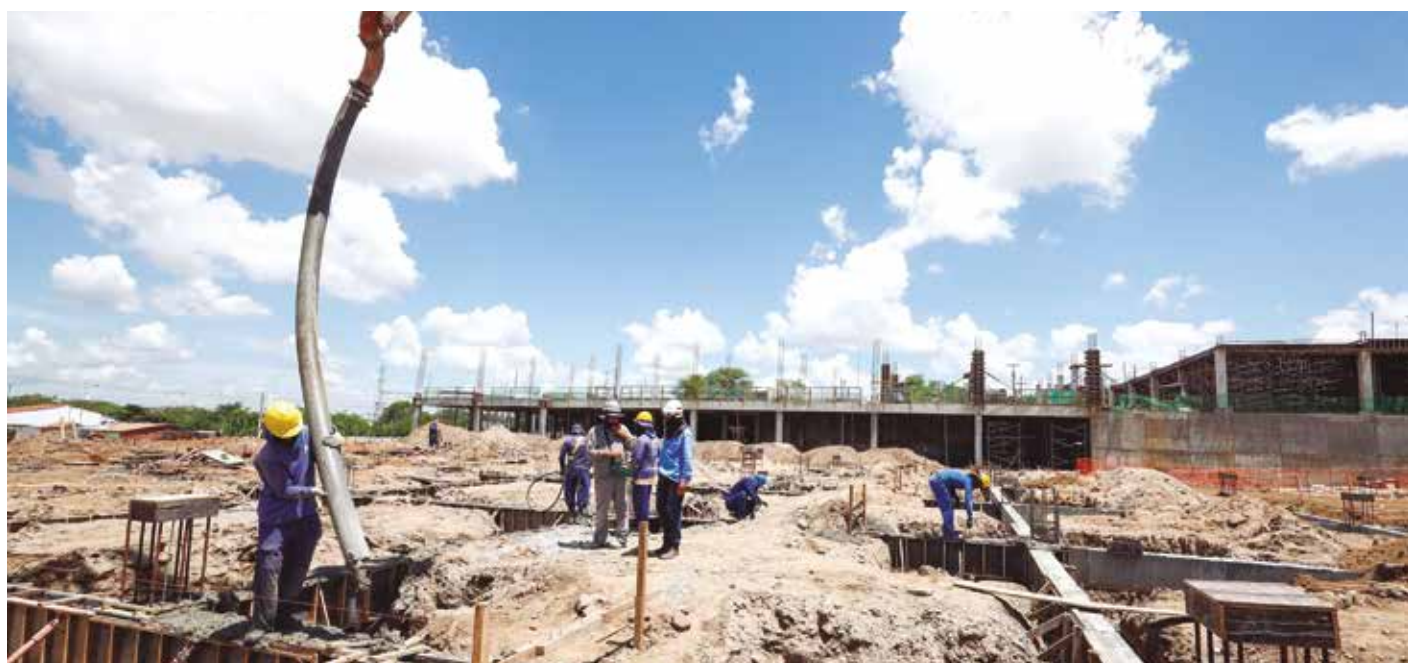
No Hospital da Mulher, os trabalhos estão em fase de preparação das estruturas; o investimento é de R$ 114 milhões
